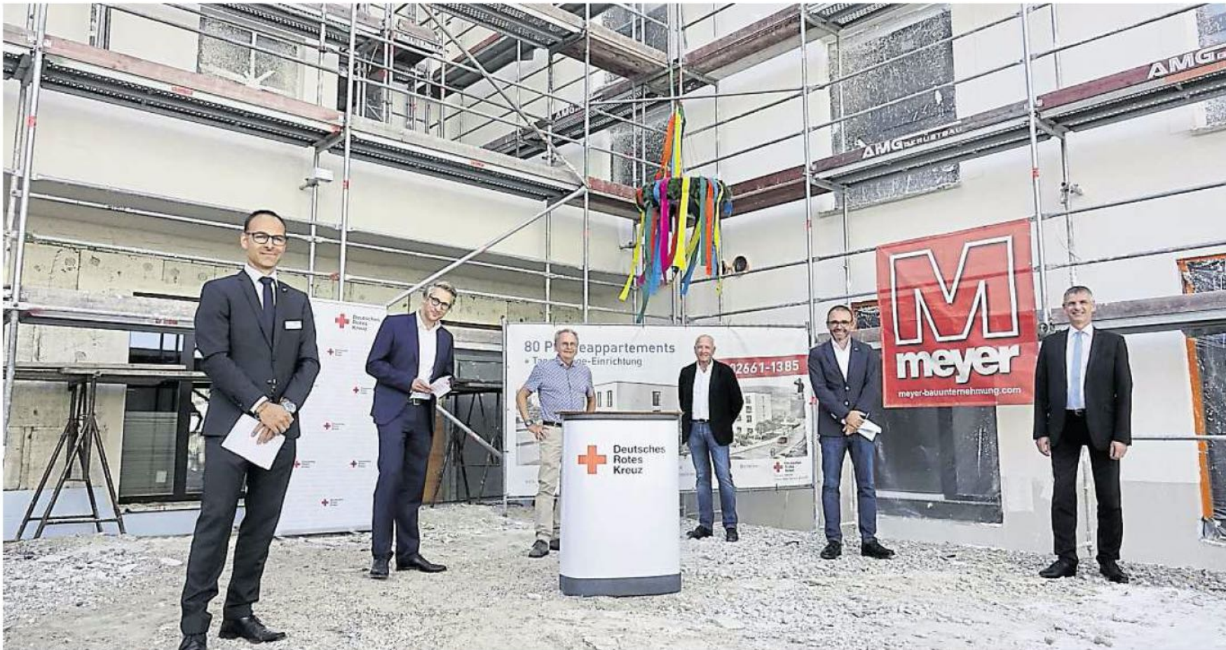
Richtfest im coronabedingt kleinem Rahmen – und später als geplant. Dafür steht der Rohbau schon fast fertig da.
